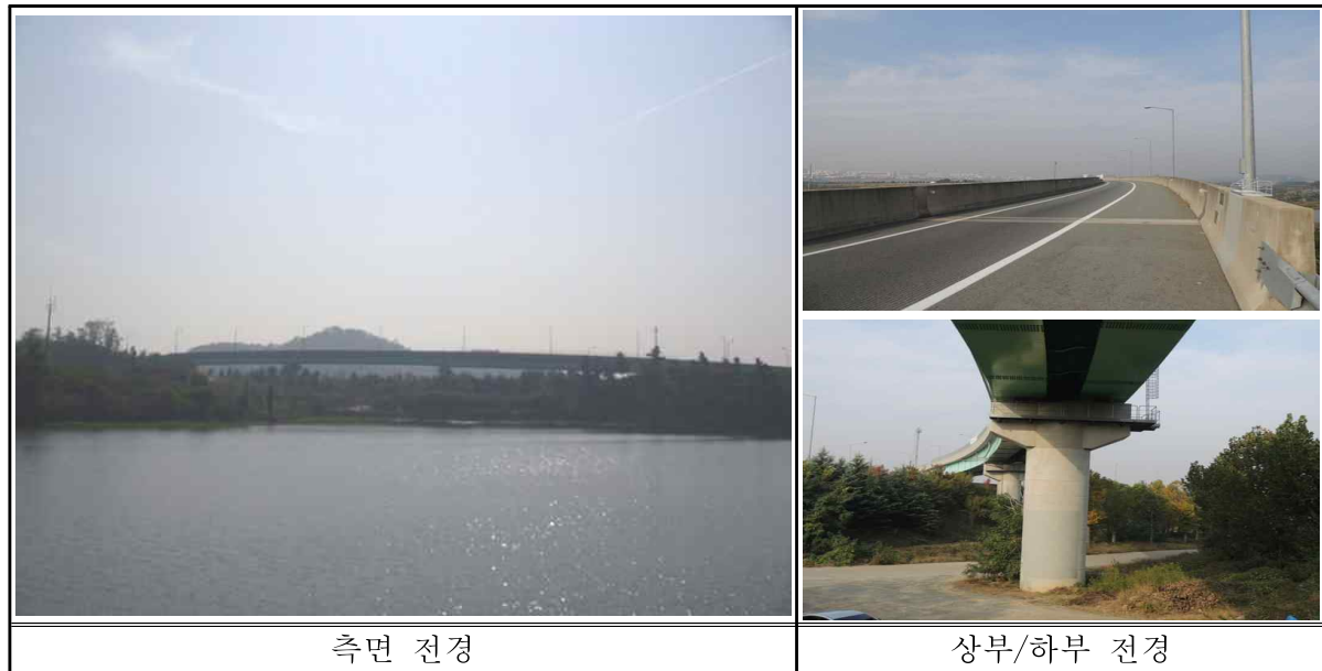
<그림 1.1.1> 동대구JCT3교 전경
